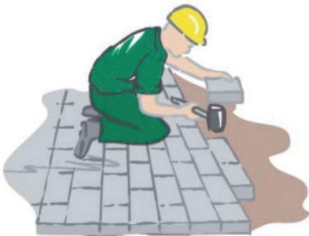
Pflastersteine lotgerecht verlegen
