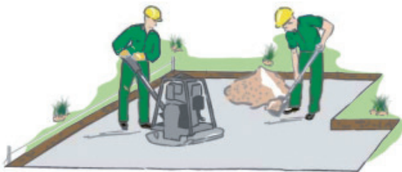
Tragschicht mit einem geeigneten Rüttler verdichten
